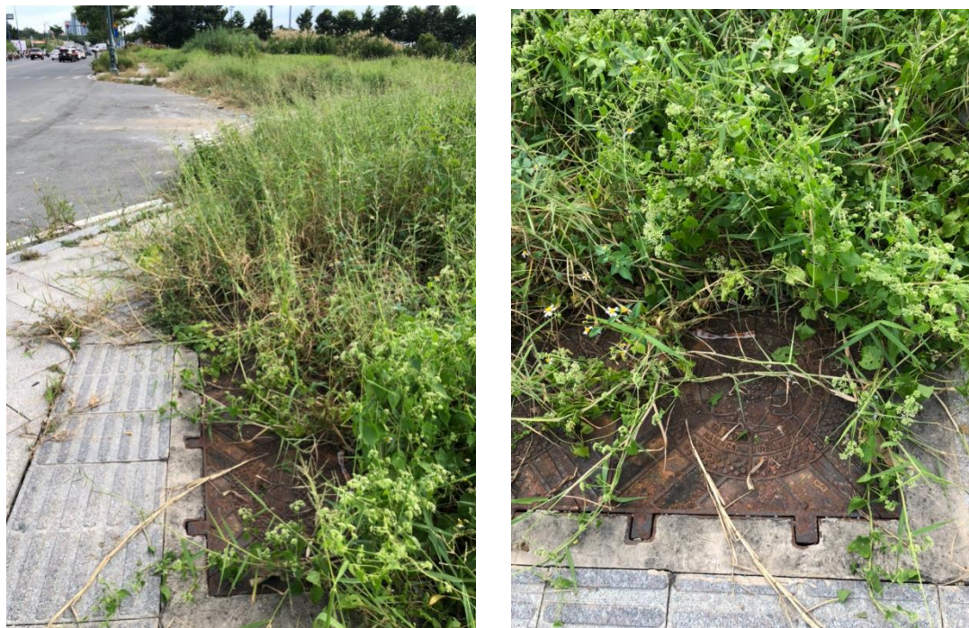
Hình 1.4. Điểm chờ đầu nối trên đường Tố Hữu
