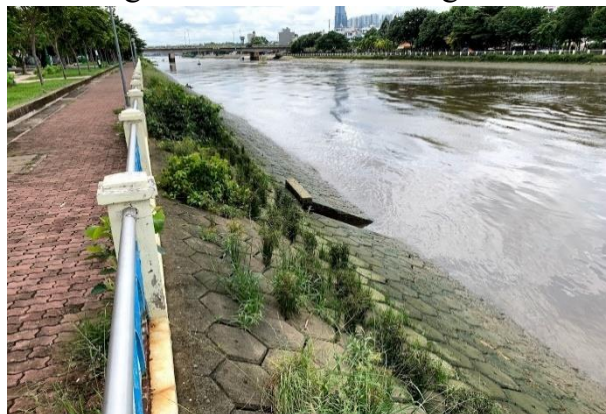
Cống xả thoát nước tại kênh Thanh Đa
