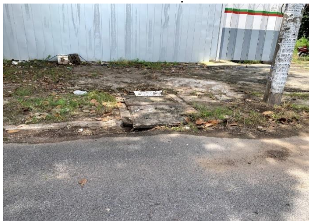
Hệ thống thoát nước trên đường số 2
