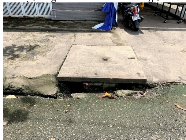
Hệ thống thoát nước trên đường số 7
