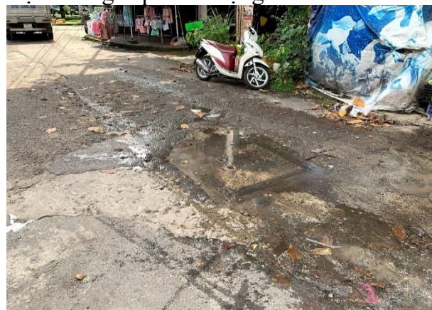
Hệ thống thoát nước trên đường số 4
