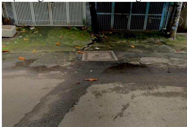
Hệ thống thoát nước trên đường số 3
