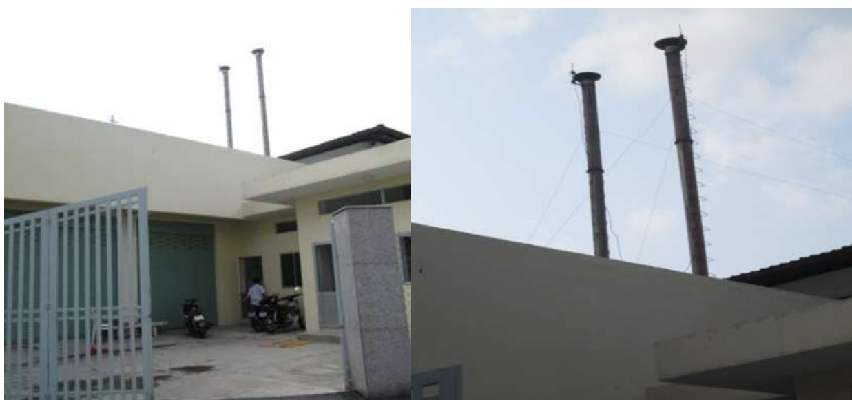
Hình 3.1: Khu vực đặt máy phát điện và ống khói
