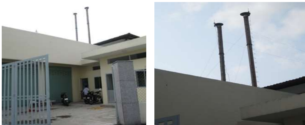
Hình 3.2: Khu vực đặt máy phát điện và ống khói
