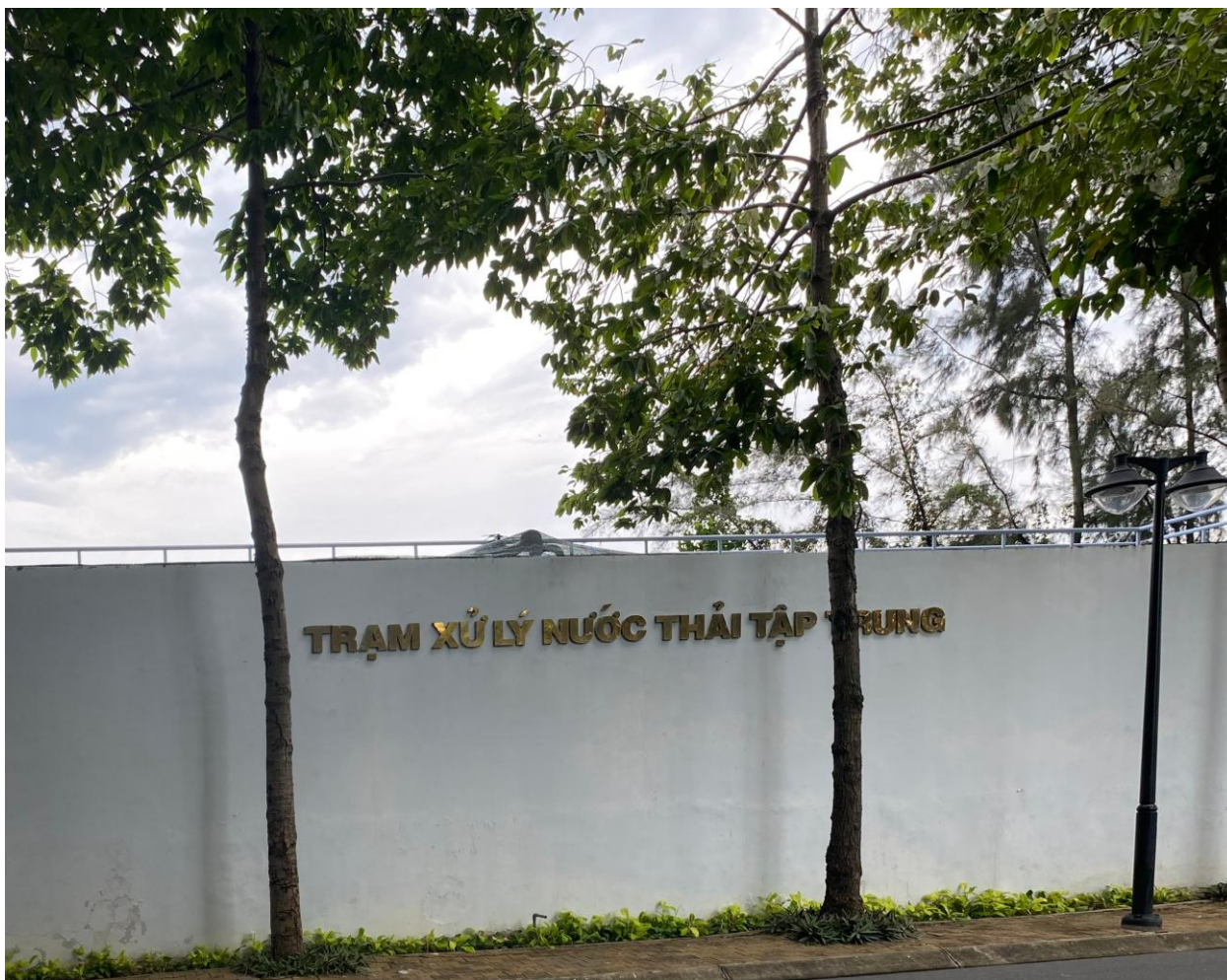
Hình 3.16 Hệ thống xử lý nước thải tập trung 1200m 3 /ngày đêm
