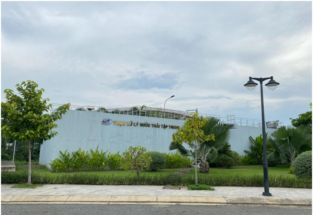
Hình 3.18 Hệ thống xử lý nước thải tập trung 410m 3 /ngày đêm
