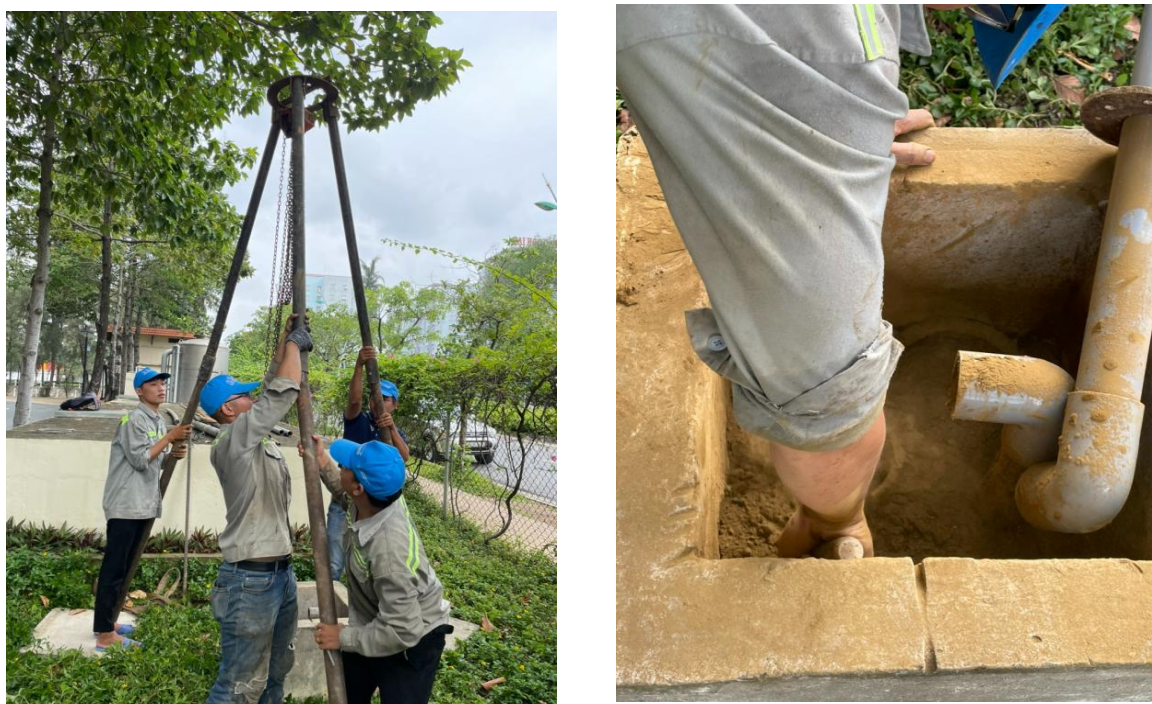
Hình 3.23 Công tác trám lấp giếng tại Trường Đại học Tôn Đức Thắng
