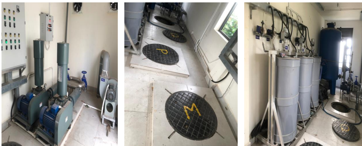
Nhà vận hành hệ thống xử lý nước thải
