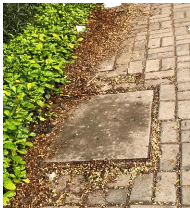
Hình 3. 4. Hình ảnh hố ga đầu nối nước thải
