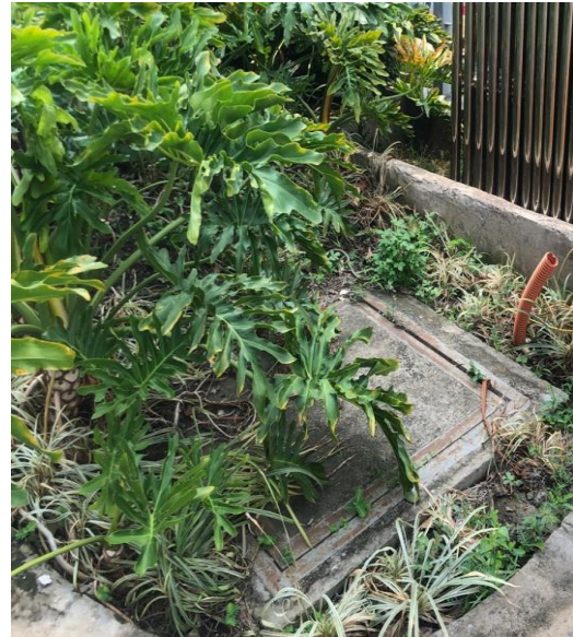
Hố ga thoát nước mưa 2 (đường Nguyễn Đồng Chi)
