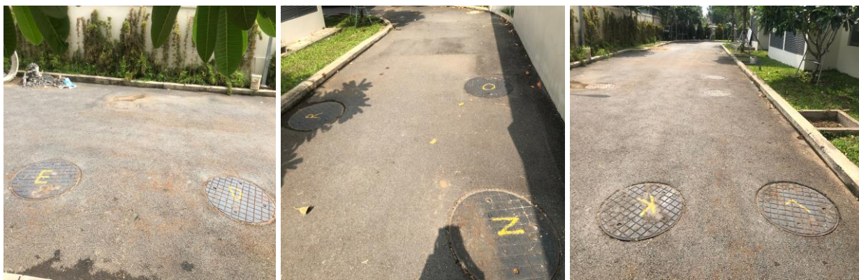
Nắp thăm của bể xử lý nước thải tại tầng trệt
