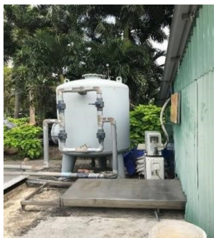
Cụm bơm, bồn lọc áp lực, bồn hóa chất
