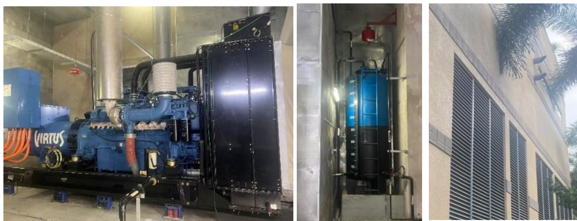
Hình 3.7: Máy phát điện dự phòng phòng Khôi chung cư Topaz
