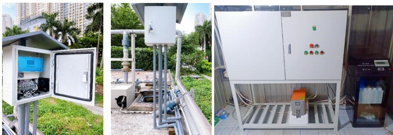
Hình 3.5: Hệ thống quan trắc tự động
