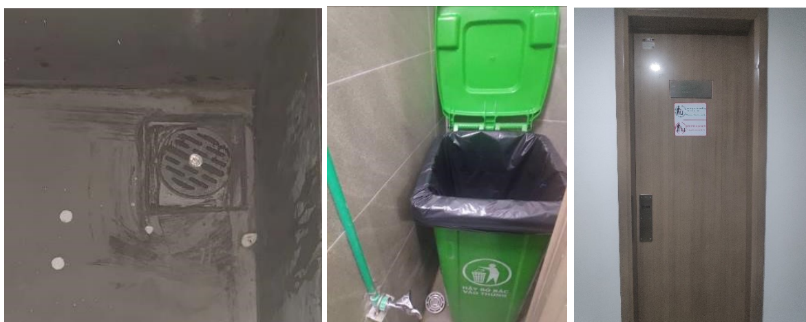
(Phòng rác tại các tầng của khu chung cư)
