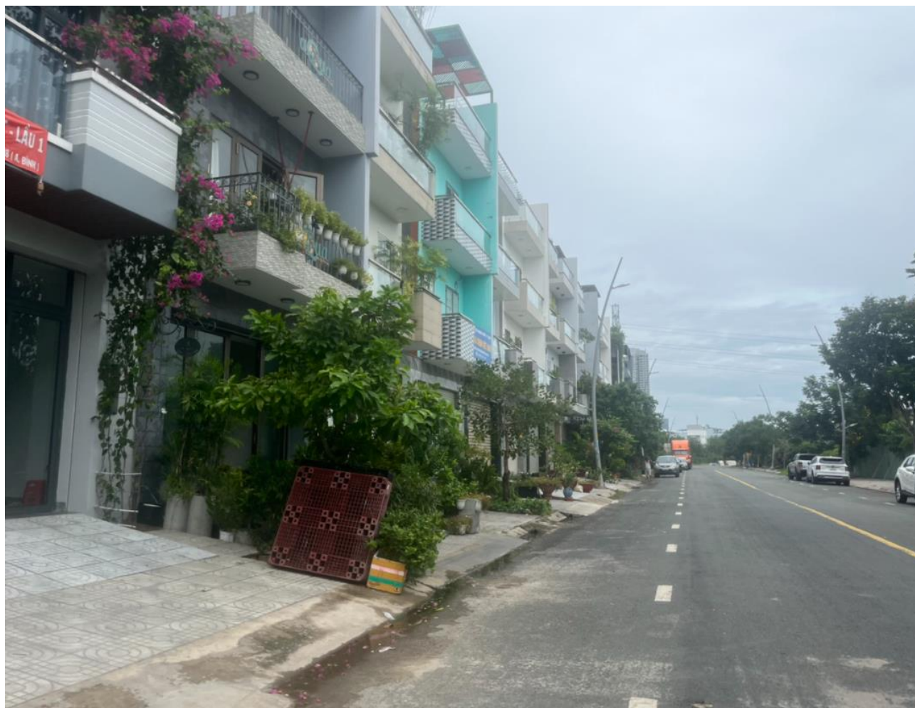
Hình 1. 3. Hiện trạng khu nhà liền kề đã được xây dựng
