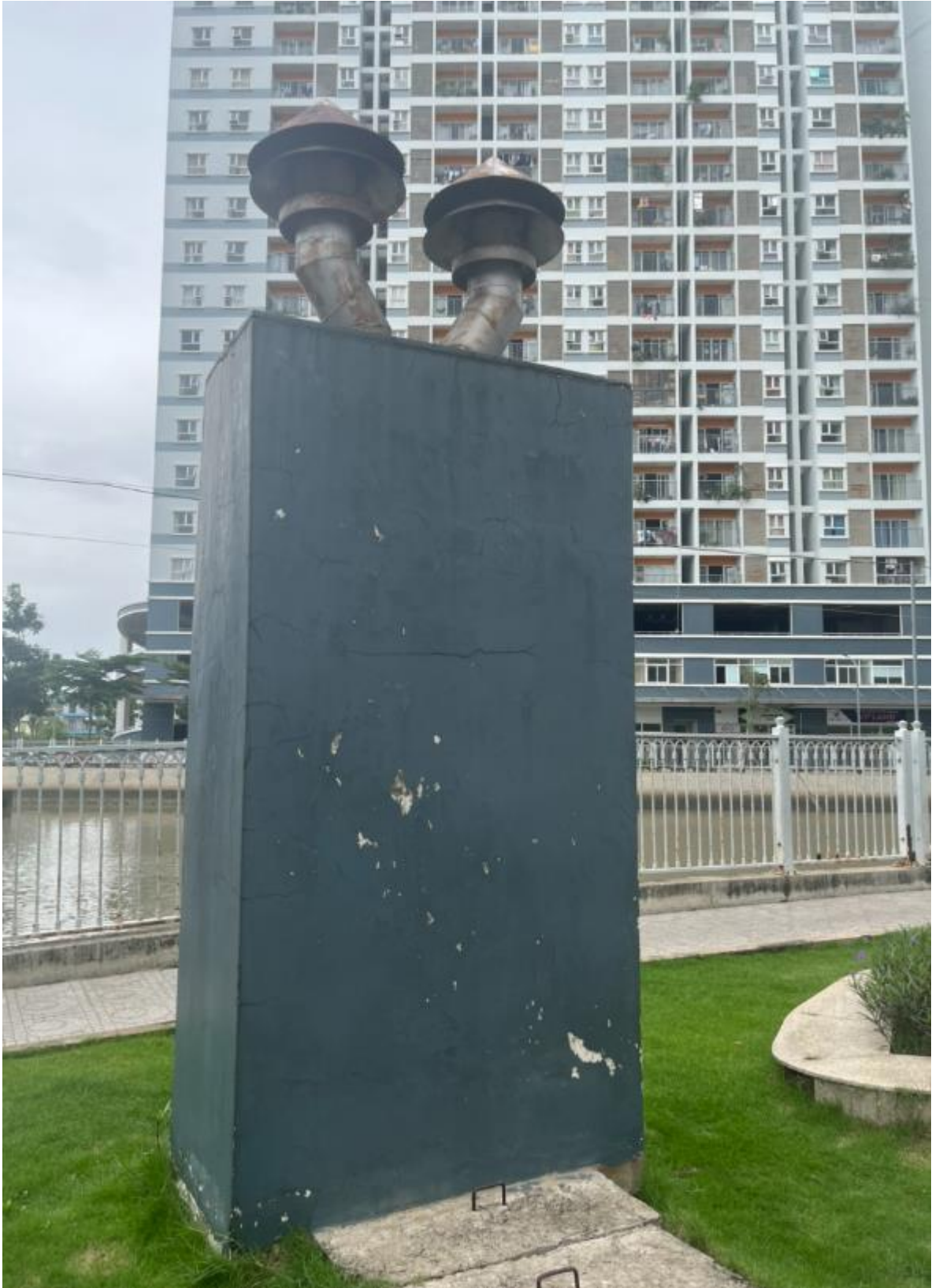
Hình 3. 16. Ống khói của máy phát điện của tháp M2
