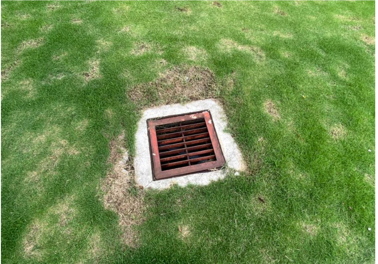
Hình 3. 7. Cổng thu gom nước mưa tại khu vực khuôn viên cây xanh
