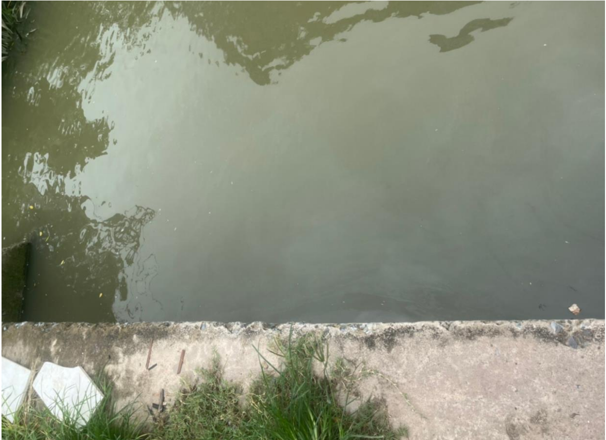
Hình 3. 5. Điểm thoát nước mưa từ hồ điều tiết vào Rạch Bà Bướm
