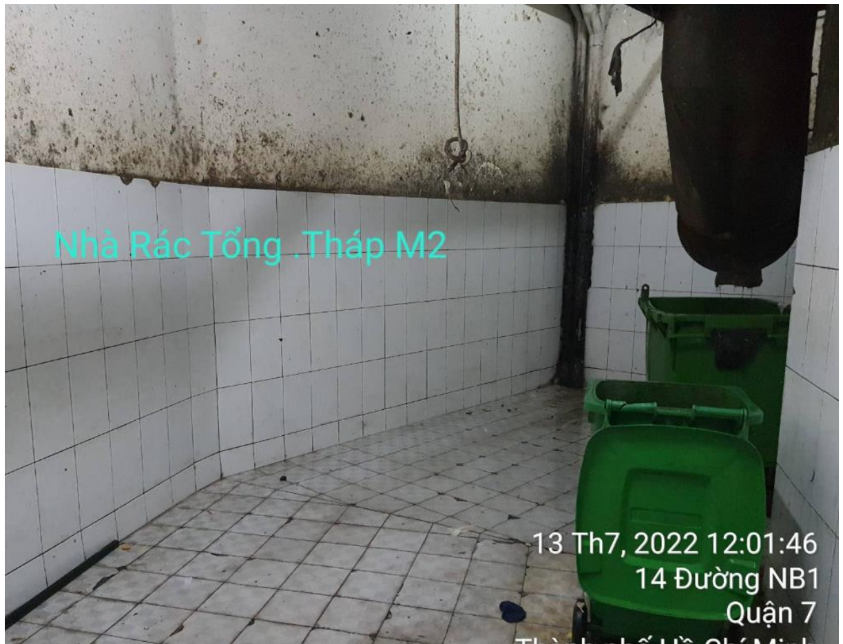
Hình 3. 21. Bên trong nhà rác tháp M2
