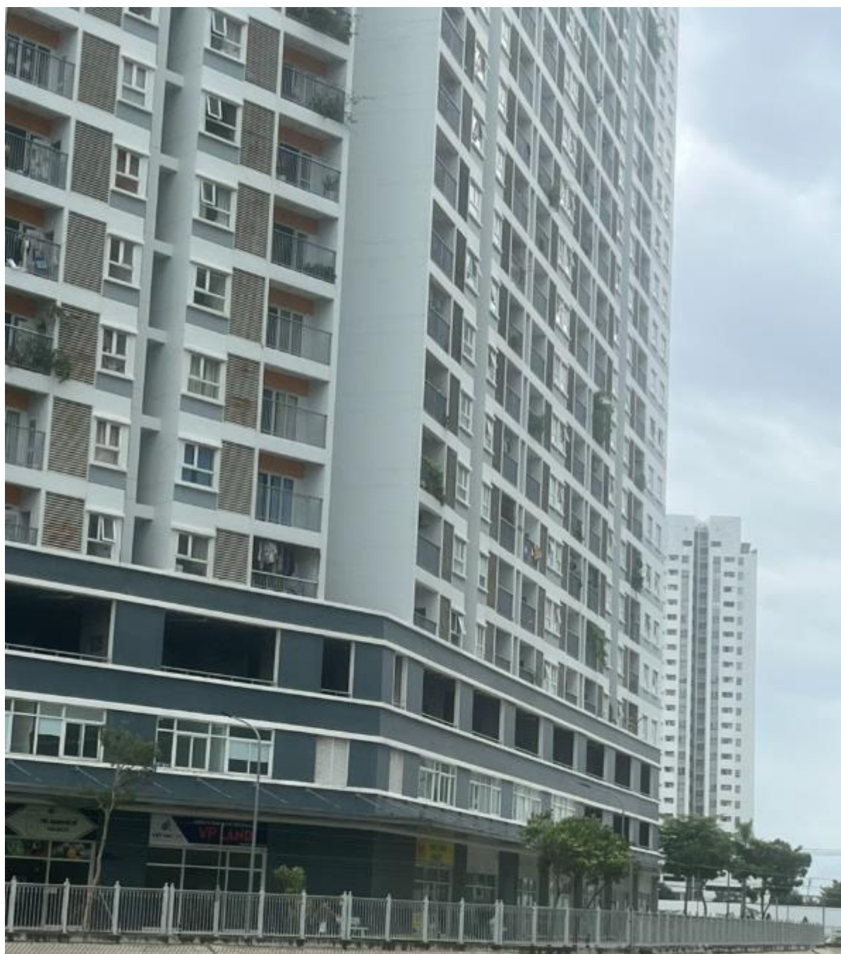
Hình 1. 2. Hiện trạng tháp M1 đã xây dựng hoàn thiện
