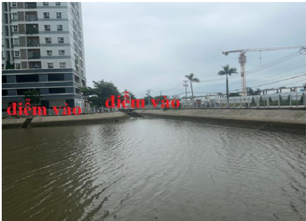
Hình 3. 3. Điểm đầu nối nước mưa của tháp M1 vào hồ điều tiết
