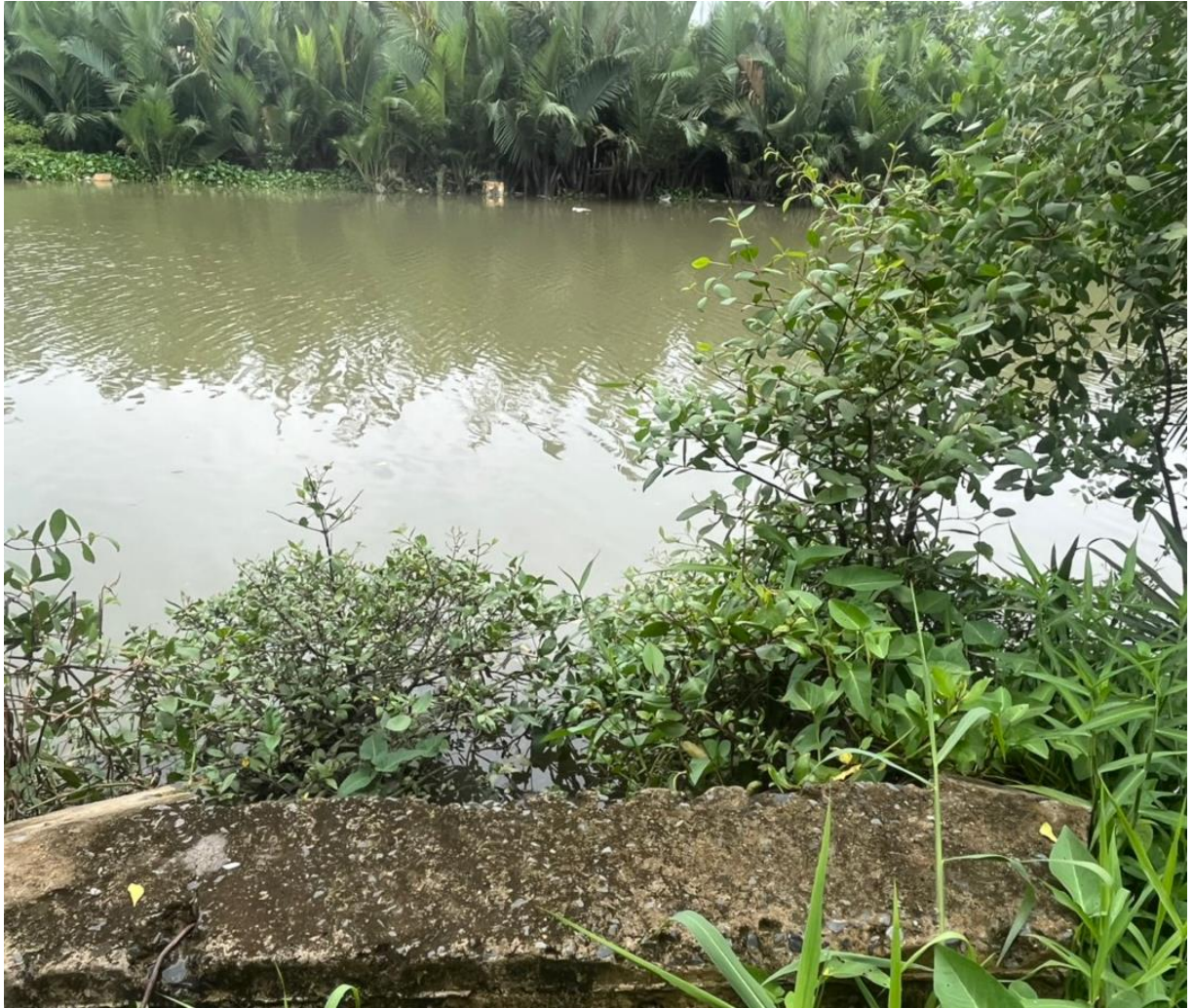
Hình 3. 6. Một điểm đầu nối nước mưa vào Rạch Bà Bướm của khu nhà liền kề
