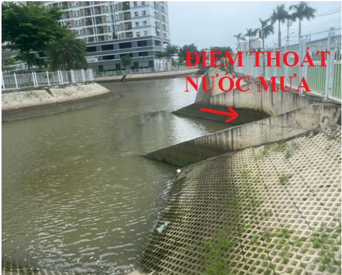
Hình 3. 4. Điểm thoát nước mưa của hồ điều tiết vào cống hộp nằm dòng rạch
