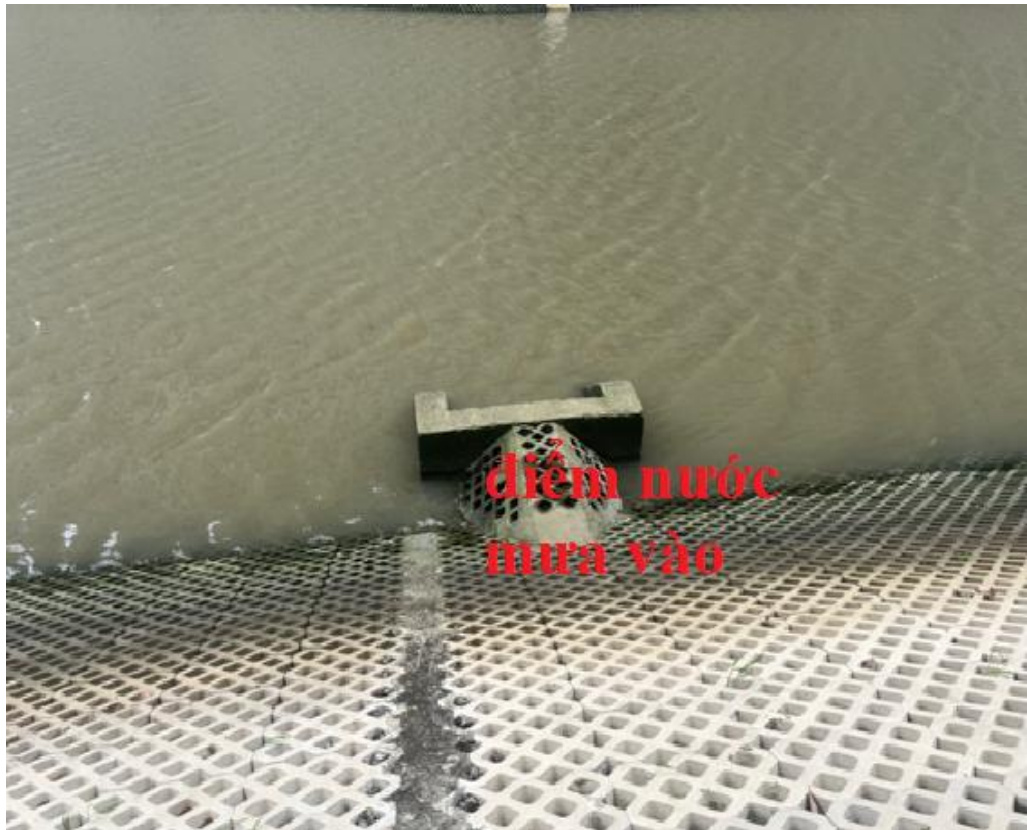
Hình 3. 2. Điểm đầu nối nước mưa của tháp M2 vào hồ điều tiết
