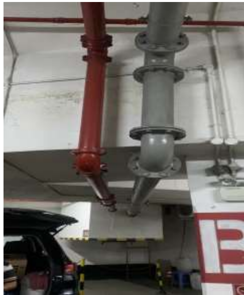
Hình 3. 6. Ống thu gom nước thải
