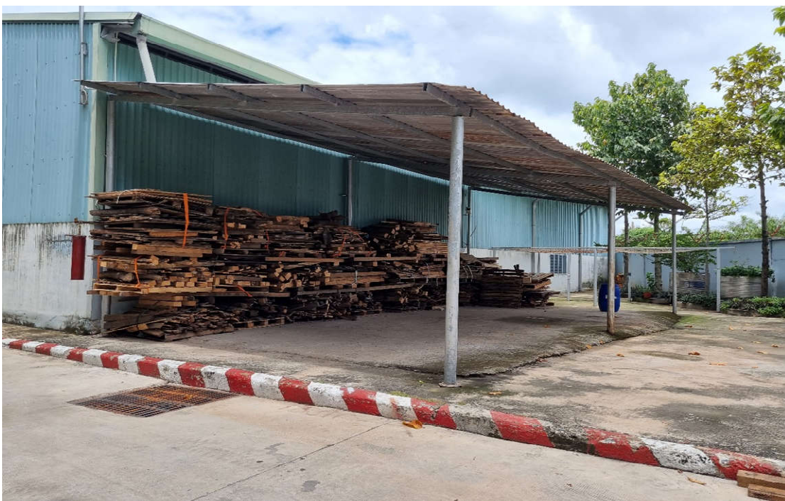
Hình 3.13 Khu vực lưu trữ chất thải công nghiệp
