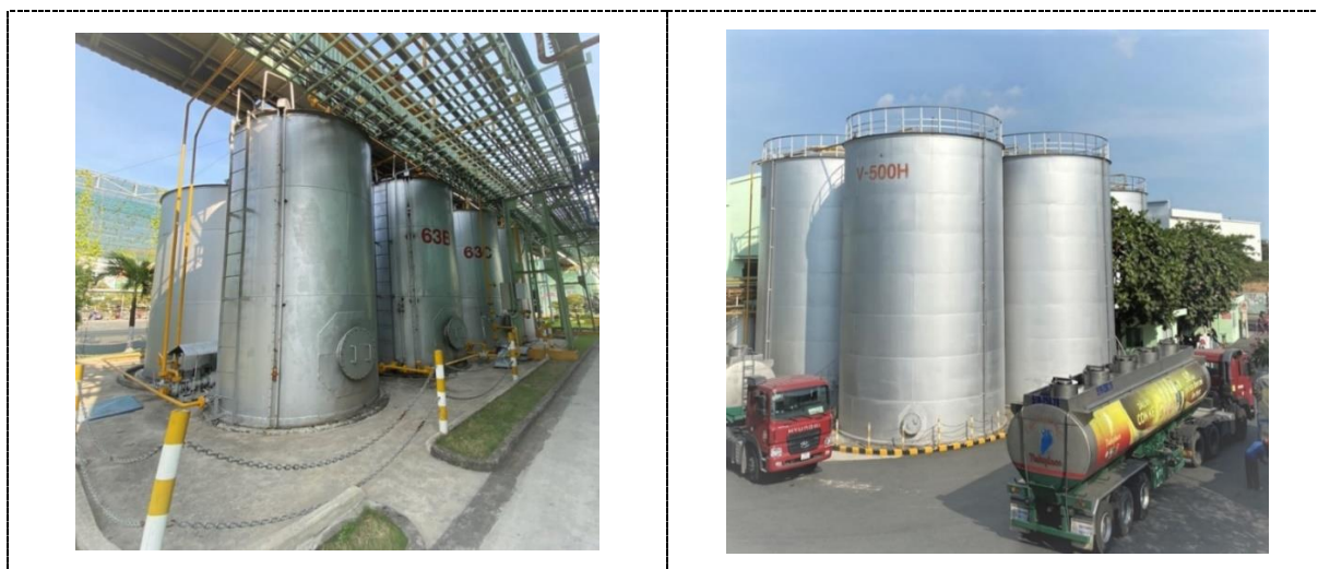
Hình 1.6. Các bồn chứa dầu của công ty
