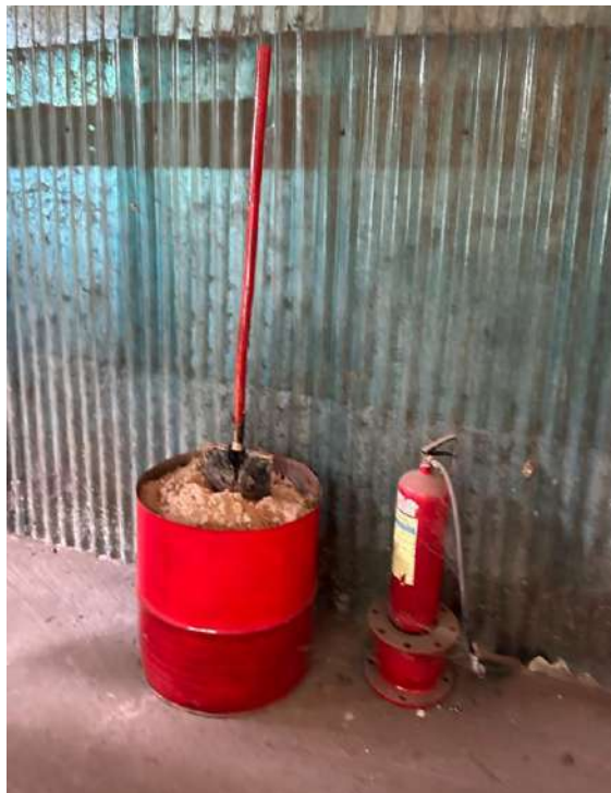
Hình 3. 14. Bố trí cát, xẻng, bình cứu hỏa tại khu vực lưu chứa chất thải nguy hại
