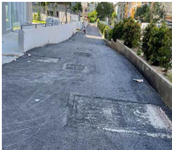
a. Bể tự hoại
