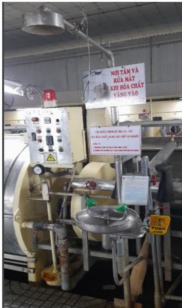
Hình 3.24: Hệ thống sơ cấp cứu bố trí tại các khu vực sản xuất khi xảy ra các tai nạn lao động
