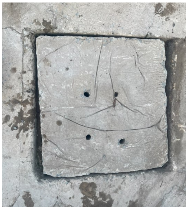
Hình 3.2 Hố ga lắng cát, rãnh thu gom nước mưa chảy tràn trên bề mặt sân trước khi thoát ra rạch Cái Trung
