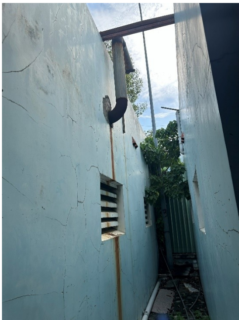
Hình 12. Ống khói máy phát điện dự phòng
