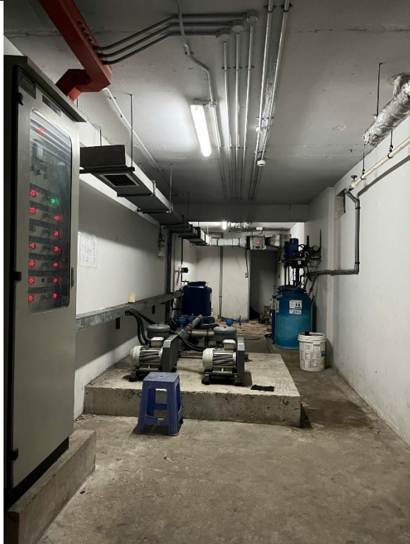
Hệ thống xử lý nước thải công suất 270 m 3 /ngày.đêm
