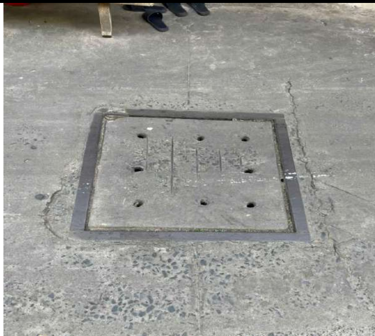
Hình 4. 1. Hồ ga tập trung nước thải từ HTXLNT của nhà máy Hữu Nghị (tại vị trí X: 1188214, Y: 599376 thuộc Hệ tọa độ VN-2000, múi chiều 3°, kinh tuyến trực 105°45')
