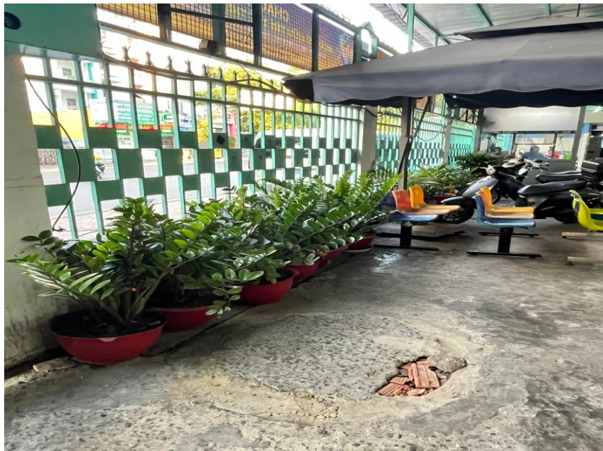
Hình 7. Hố ga đầu nối sau hệ thống xử lý nước thải
