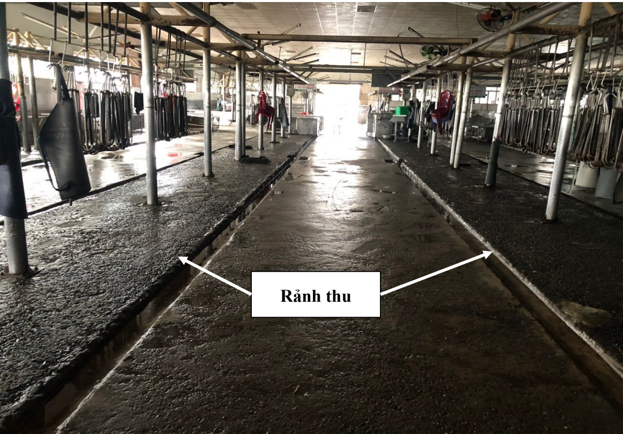
Hình 10. Thu gom nước thải từ khu nhà lồng chợ thịt
