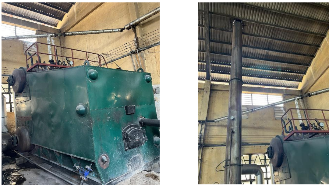
Hình 3.9. Hệ thống đường ống thu gom và quạt hút khí thải tại cơ sở
