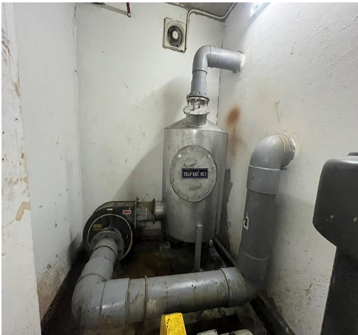
Hình 3. 5. Tháp xử lý mùi tại hệ thống xử lý nước thải của cơ sở
