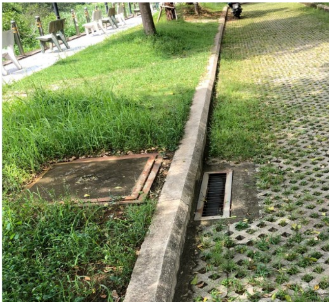
Hình 3. 4: Hồ ga thoát nước mưa bên trong
