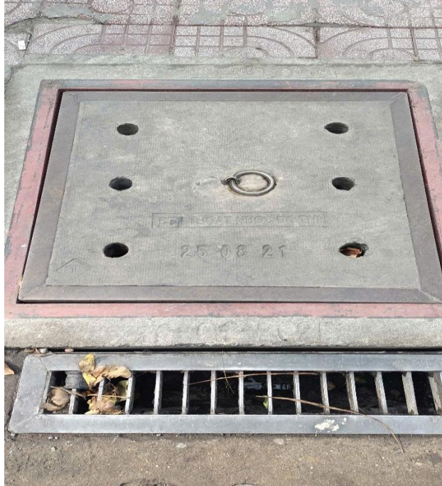
Hình 3.2. Hố ga đầu nối nước thải của cơ sở
