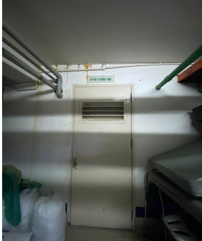
Hình 3.20. Khu vực điều hành của hệ thống xử lý nước thải
