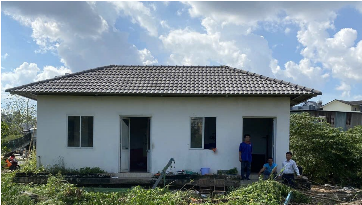
Hình III. 7. Nhà điều hành Trạm xử lý nước thải (giai đoạn 1 - công suất 250 m 3 /ngày đêm)
