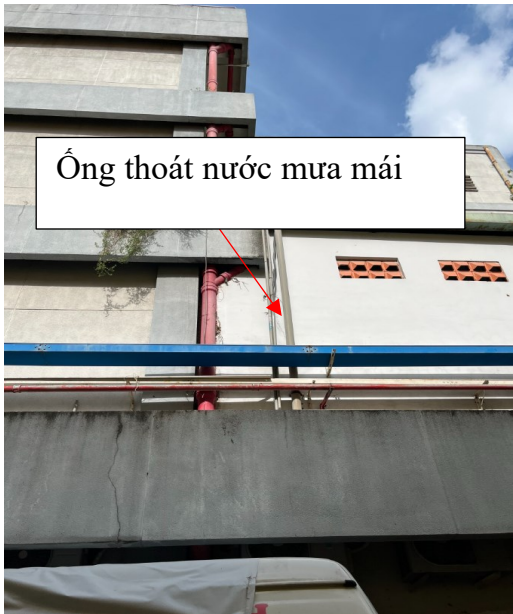
Hình 3. 2. Cống thoát nước mưa và ống thoát nước mưa mái
